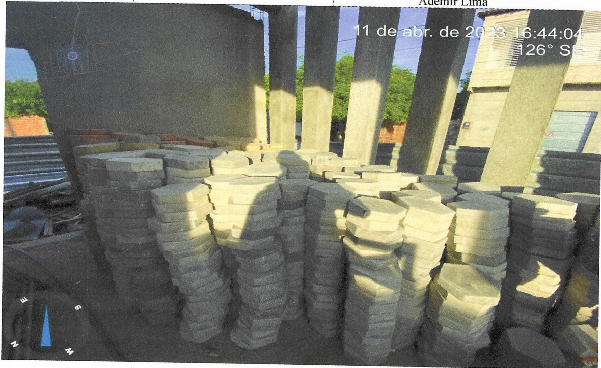
FOTO 13 - PISO INTERTRAVADO, COM BLOCO SEXTAVADO DE 25 X 25 CM, ESPESSURA 6 CM
