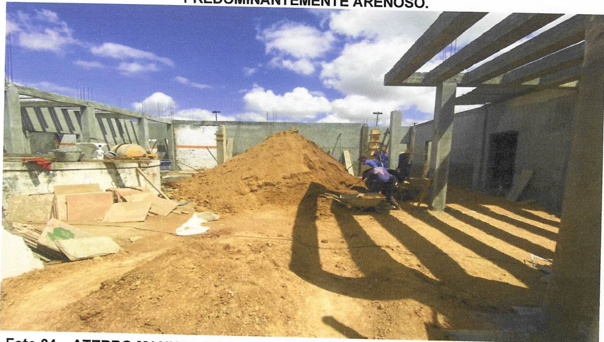
Foto 04 – ATERRO MANUAL DE VALAS COM AREIA PARA ATERRO E COMPACTAÇÃO MECANIZADA. AF_05/2016
