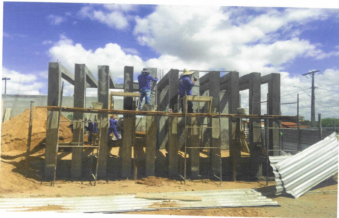
Foto 06 – EXECUÇÃO DE ESTRUTURAS DE CONCRETO ARMADO PERGOLADO.
