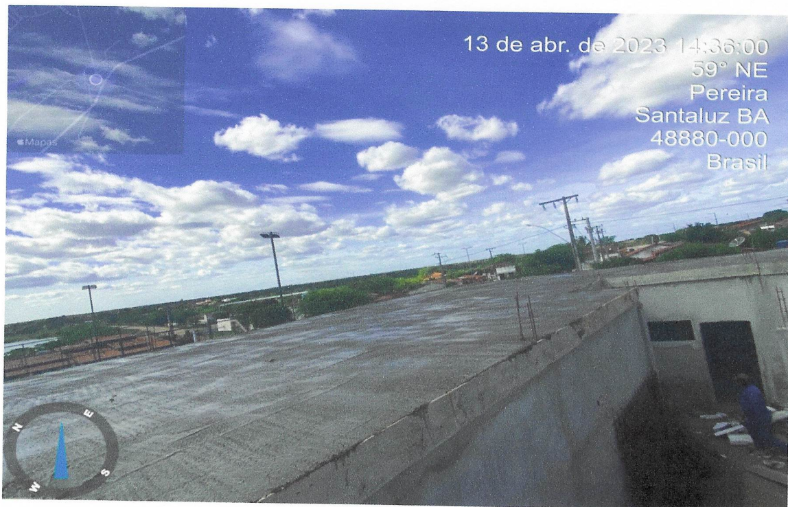
Foto 16 – Concretagem Laje
