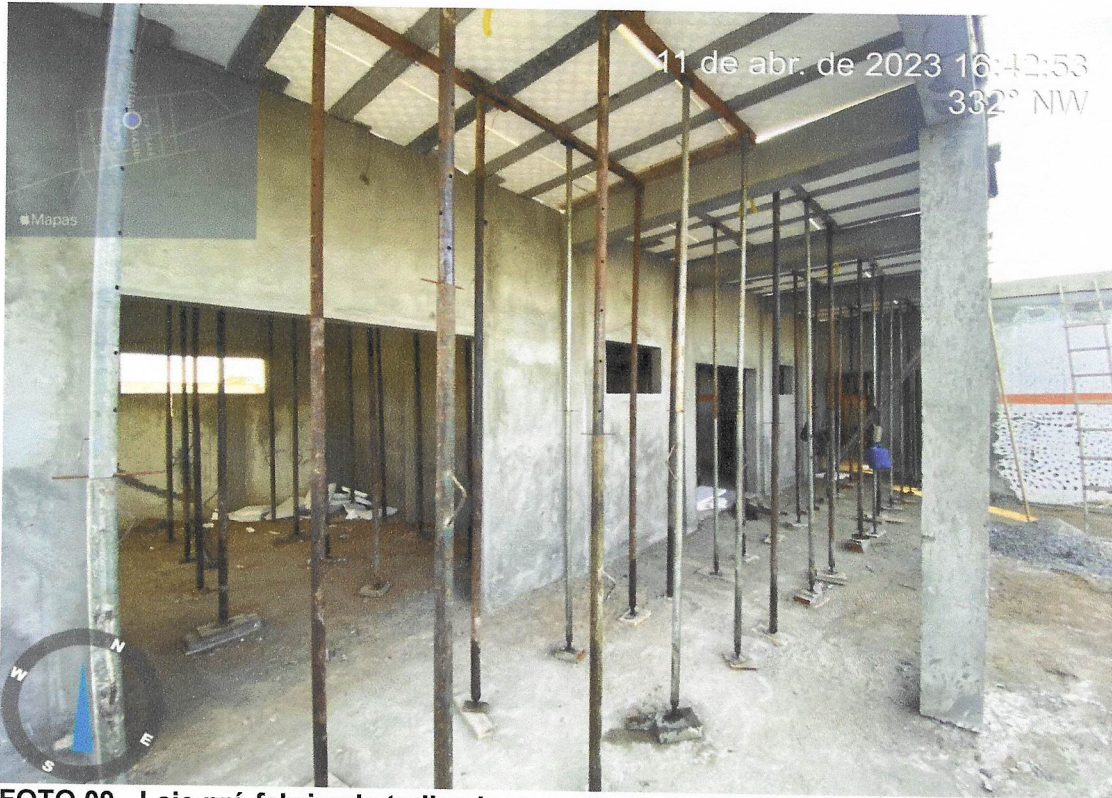
FOTO 09 - Laje pré-fabricada treliçada com vigota dupla para piso, intereixo 38cm, h=12cm.
