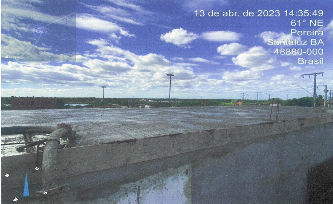
Foto 17 – Concretagem Laje
