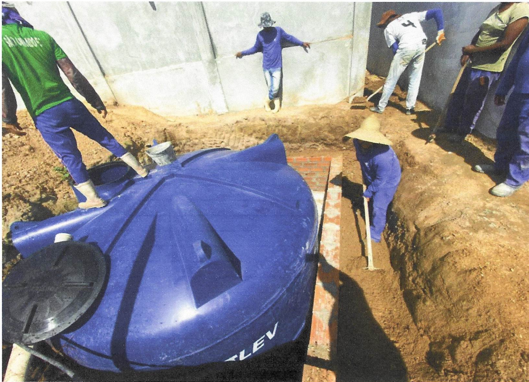
Foto 18 – Levante de Alvenaria para reservatório
