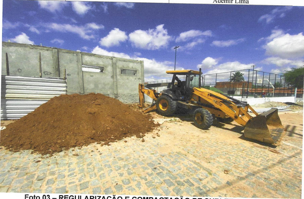
Foto 03 – REGULARIZAÇÃO E COMPACTAÇÃO DE SUBLEITO DE SOLO PREDOMINANTEMENTE ARENOSO.
