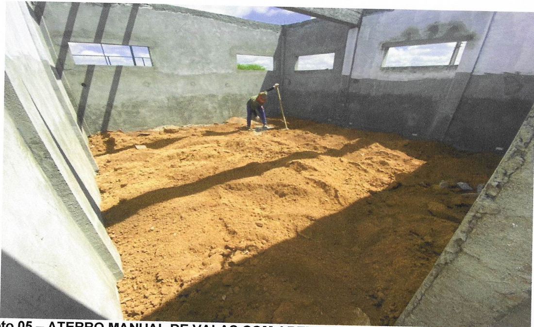
Foto 05 – ATERRO MANUAL DE VALAS COM AREIA PARA ATERRO E COMPACTAÇÃO MECANIZADA. AF_05/2016.
