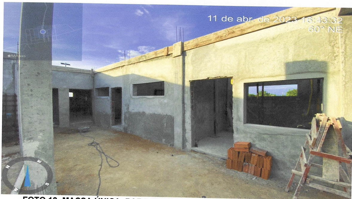
FOTO 12 -MASSA ÚNICA, PARA RECEBIMENTO DE PINTURA OU CERÂMICA, ARGAMASSA INDUSTRIALIZADA,
