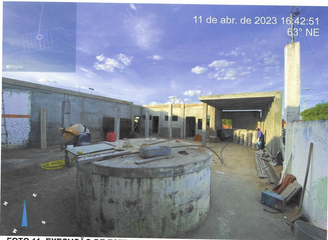
FOTO 11 -EXECUÇÃO DE ESTRUTURAS DE CONCRETO ARMADO PERGOLADO.
