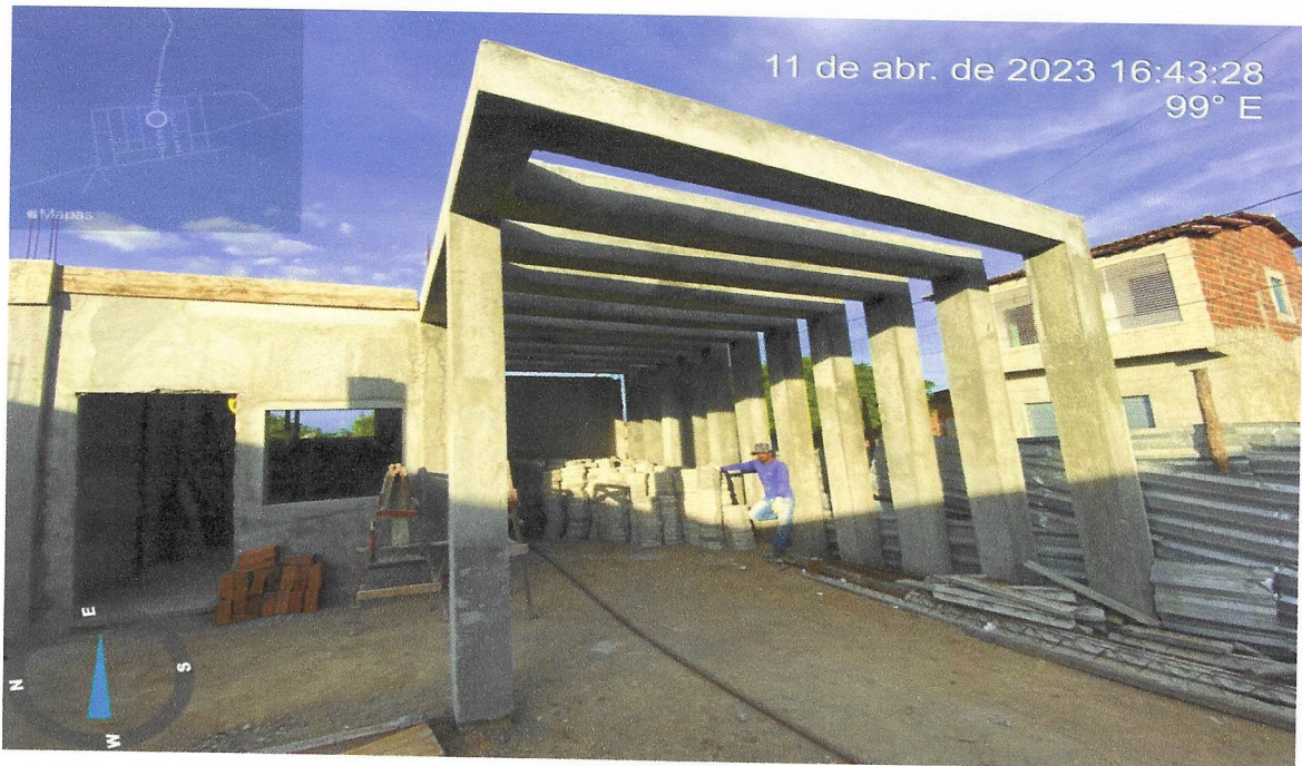
FOTO 10 - EXECUÇÃO DE ESTRUTURAS DE CONCRETO ARMADO PERGOLADO.
