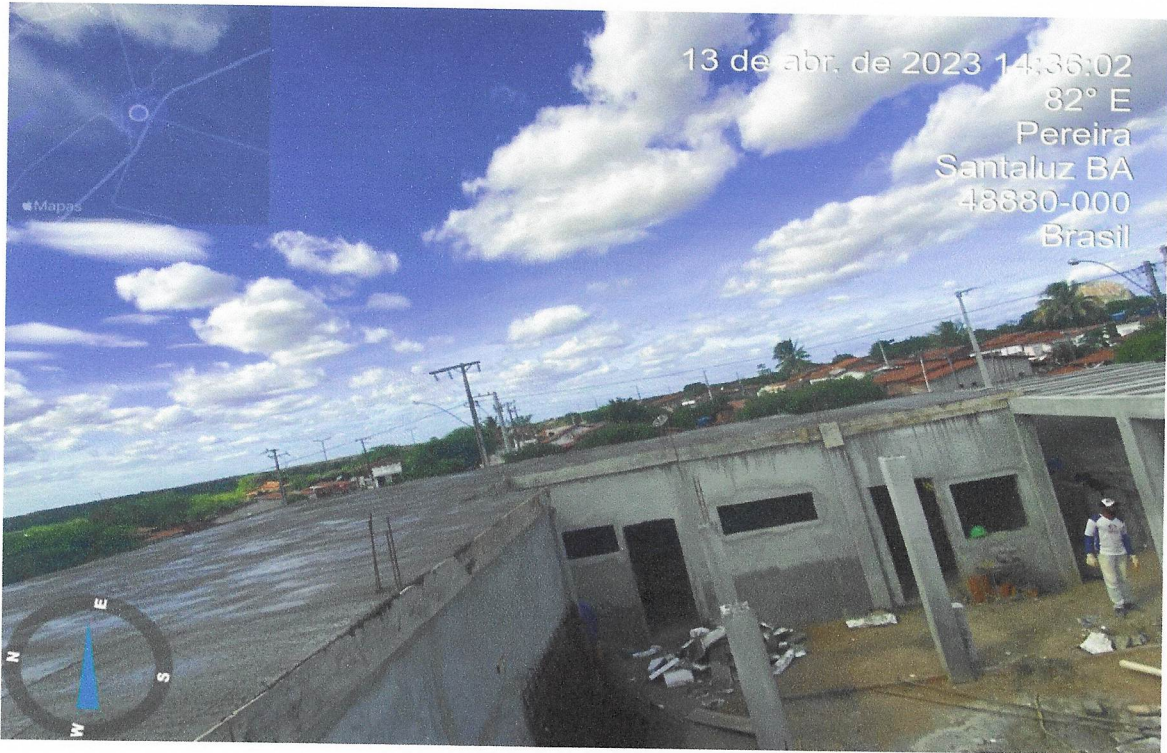
Foto 15 – Concretagem da Laje
